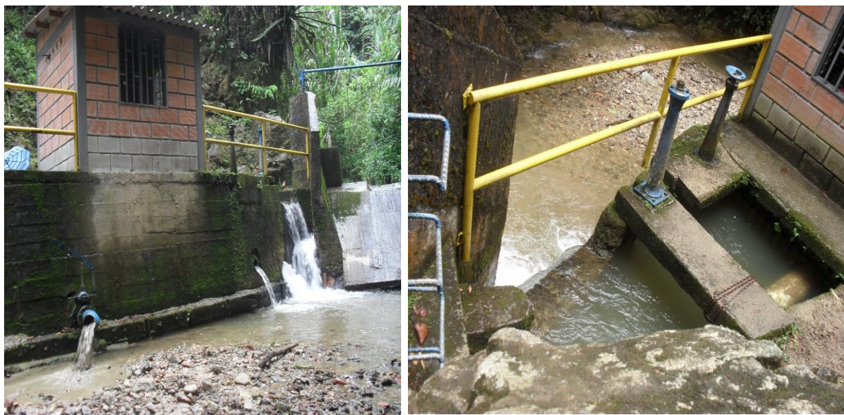
Foto 4. Canal de entrada y desarenador
